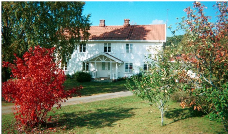
Tonerbygningen etter siste ombygging. Huset har fått ny veranda og nytt tak.
